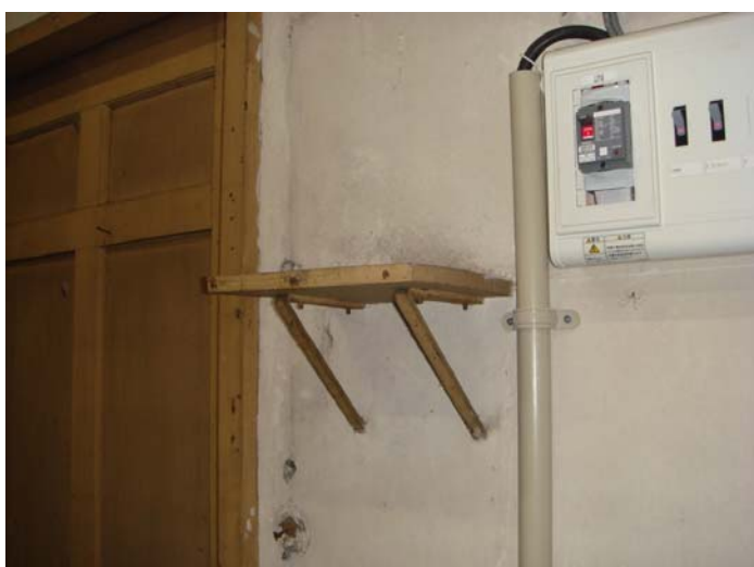
写真3 高度軸を照らすランタン用の棚
