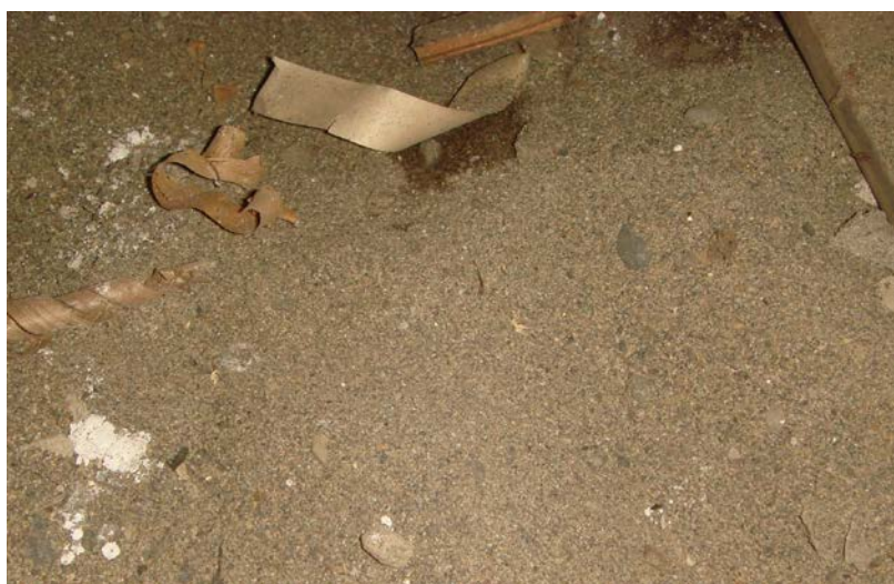
写真10 床下の砂の様子 非常に乾燥している
