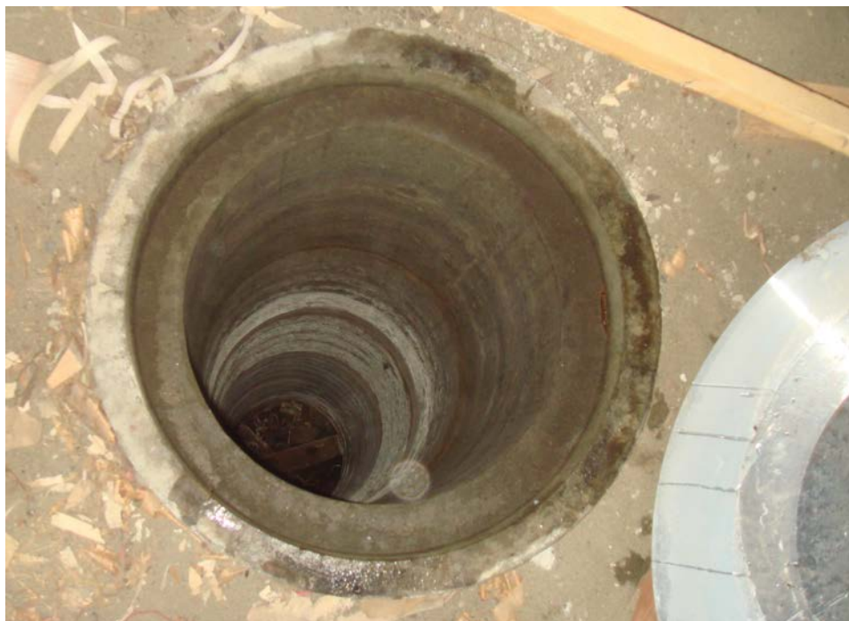
写真8 レプソルド子午儀室床下の水抜き井戸、右は蓋
