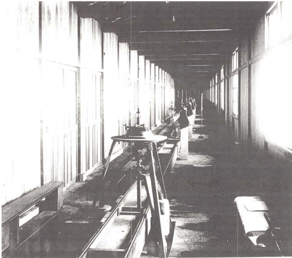
写真4 菱形基線基線尺試験室の建物の内部
