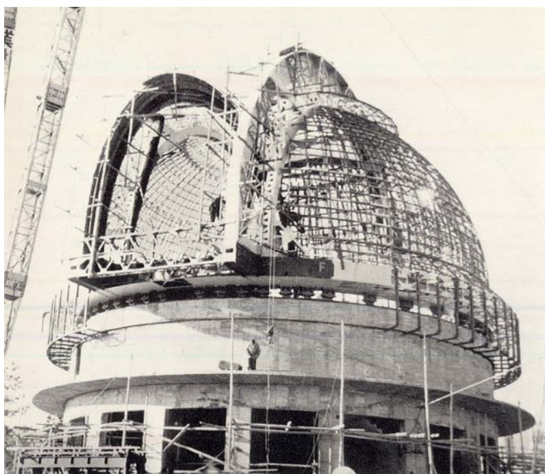
写真3 建設中の188cm望遠鏡ドーム
