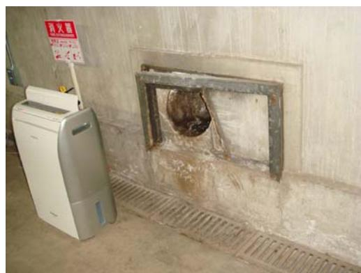
写真1 塔望遠鏡地下分光室の穴
