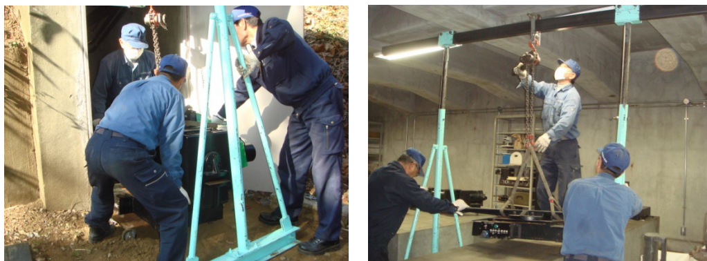
写真 7 門型クレーンを用いた搬入作業
