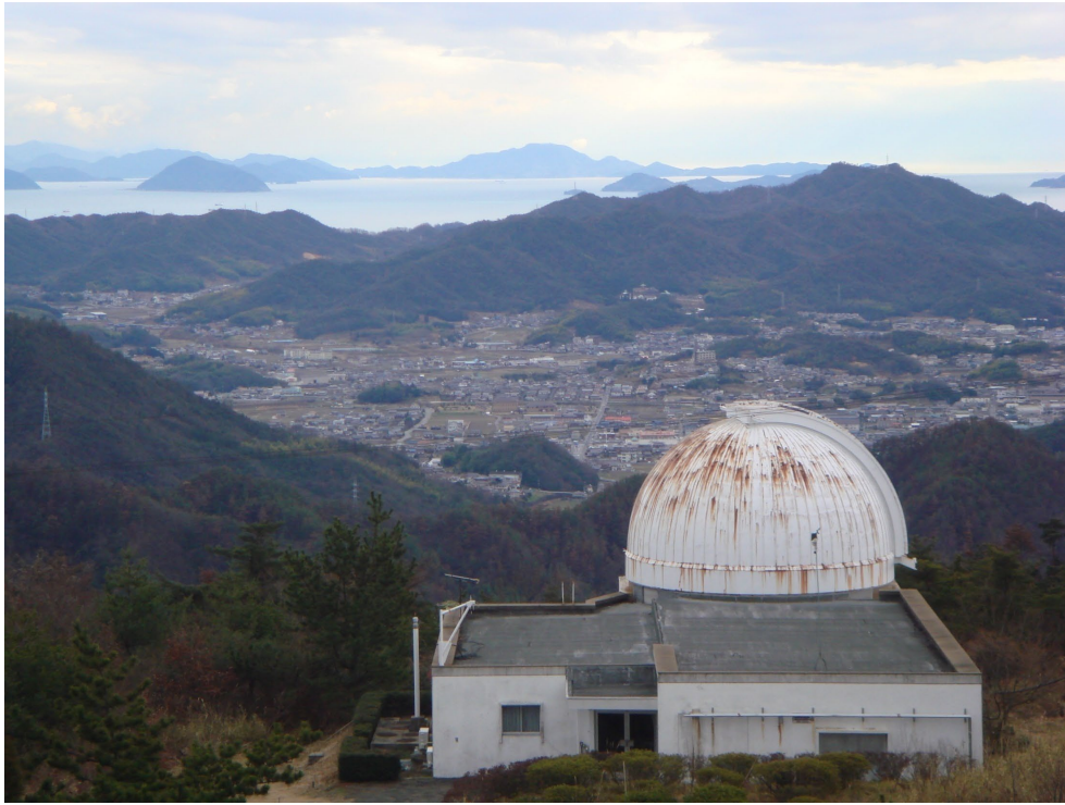
写真2 錆が出始めた65cmクーデ型太陽望遠鏡ドーム
