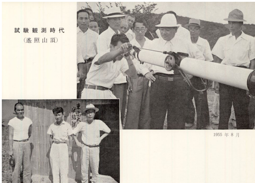
写真5 サイト調査を県知事が視察した写真
