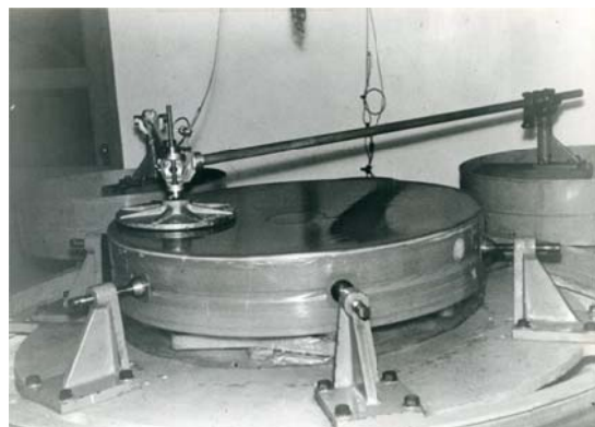
写真 4 研磨中の 91 cm 主鏡
