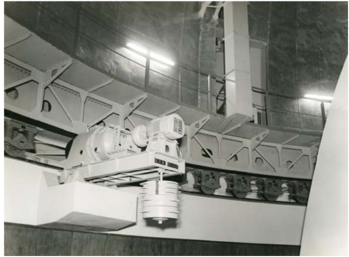
写真 13 ドーム回転機構
