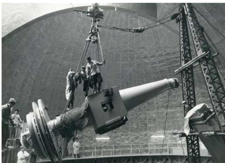
写真 6 極軸の組み付け
