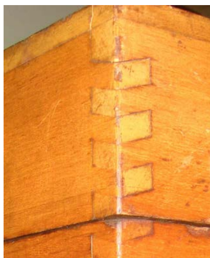
写真 2 斜めの木組み
