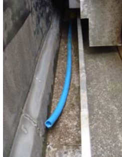
写真 6 樋上のホース
