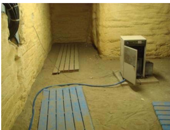
写真4 除湿機からの水ホース
