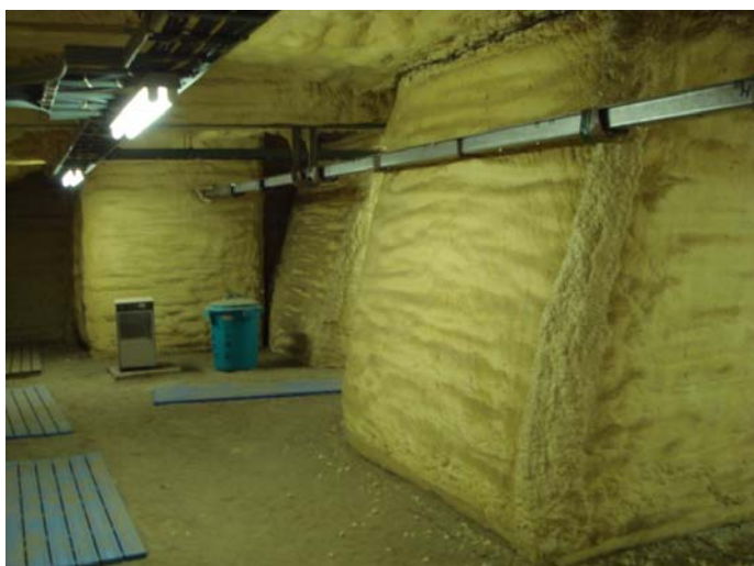
写真1 断熱材で蔽われたピア
