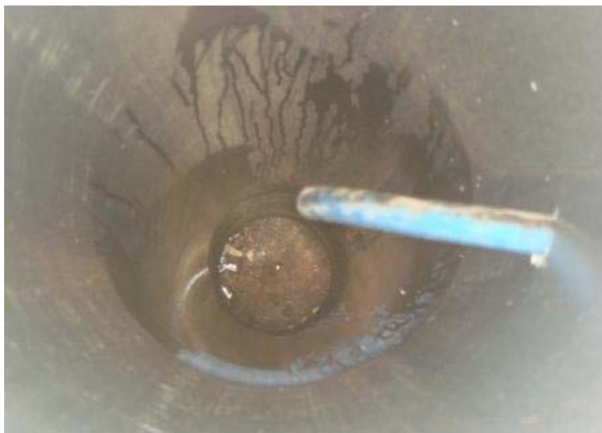
写真5 水抜き井戸の中 白い小さな点が水滴の落ちる場所
