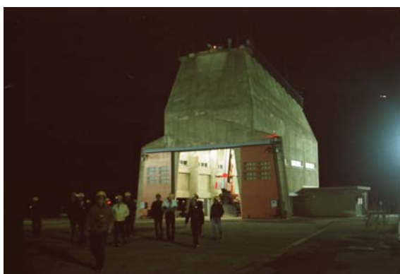
写真13 発射ドームに据付け
