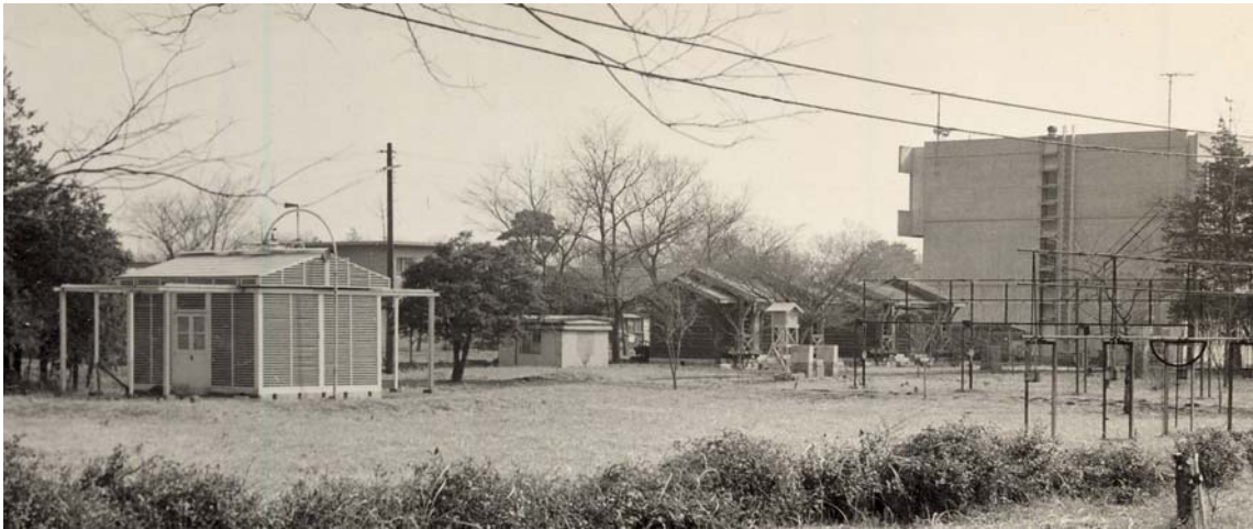
写真6 PZT 観測室、そして連合子午儀室、北研究棟が見える。
