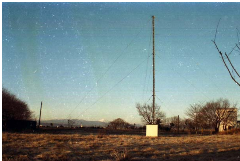
写真1 三鷹構内での接地乱流層測定鉄塔
