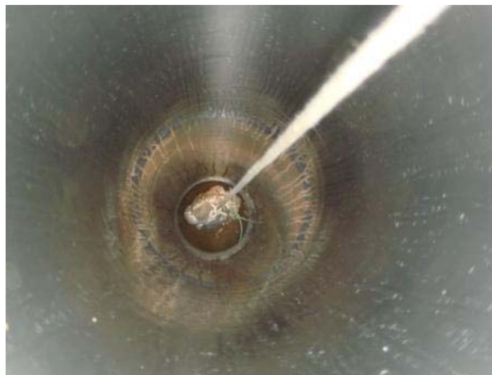
写真4 引き上げられるなぞの物体
