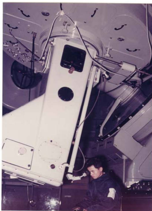
写真2 188cm 望遠鏡とカセグレン分光器 写真3 カセグレン分光器で観測する筆者 この2つあったカセグレン分光器は、一つはガラスプリズムを使ったF10、F3の分光器、
