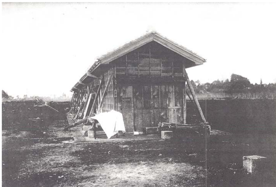
写真 2 菱形基線 基線尺試験室の建物
