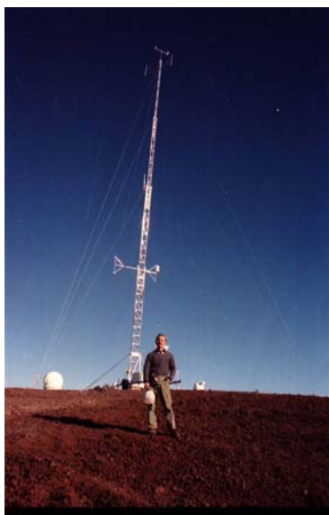
写真 5 30m 微熱測定鉄塔
