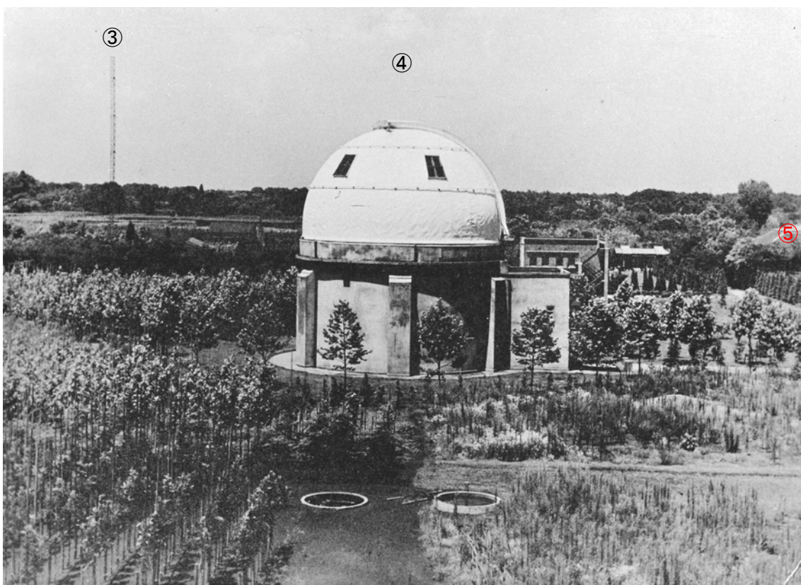
写真 1 ドームの窓がはっきりと写った昭和 20 年以前の写真
