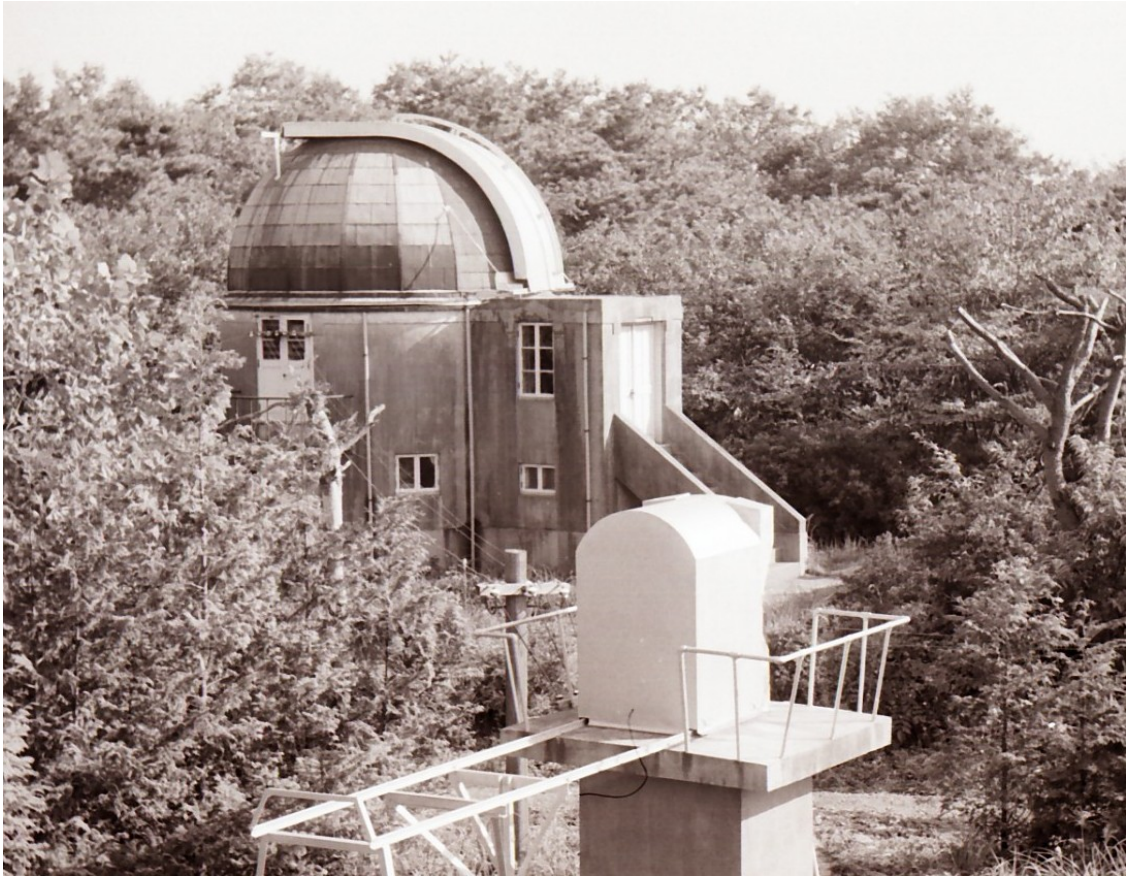
写真2 構内最南端近くのブラッシャードーム
