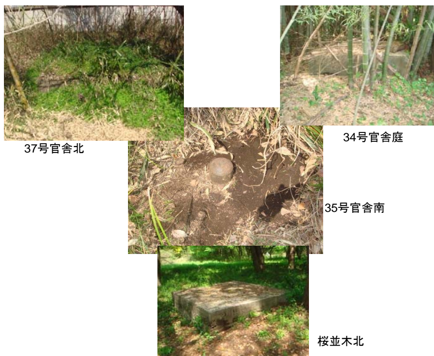
図3(写真) 図1の⑨の鉄塔の基礎とステアのコンクリート基礎
