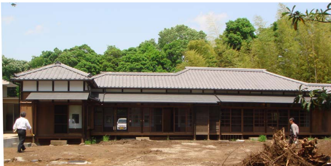
写真5 改築後の1号官舎南側
