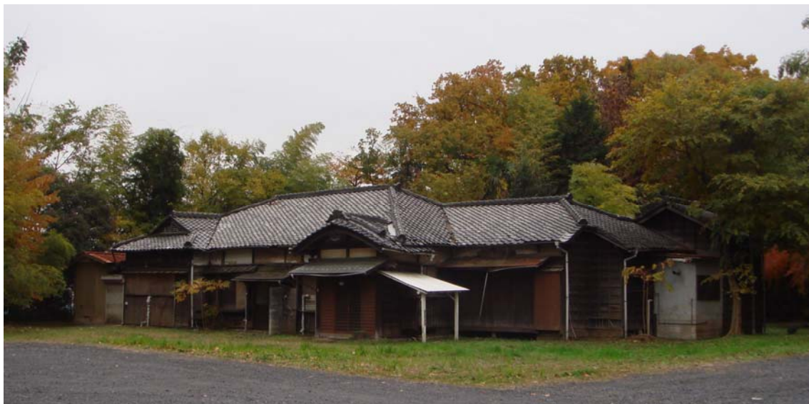
写真1 解体前の1号官舎
