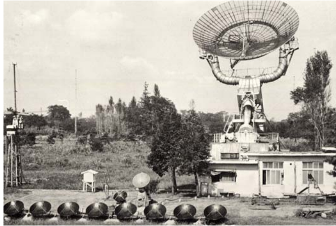
写真3 200MHz用10mパラボラアンテナ
