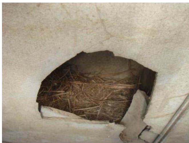
写真5 二重壁の穴の鳥の巣の痕跡
