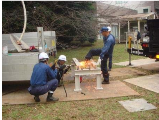
写真11 架台の修整作業
