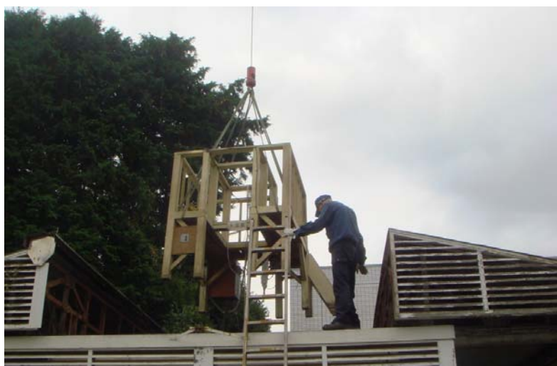
写真6 吊り出される観測用足場
