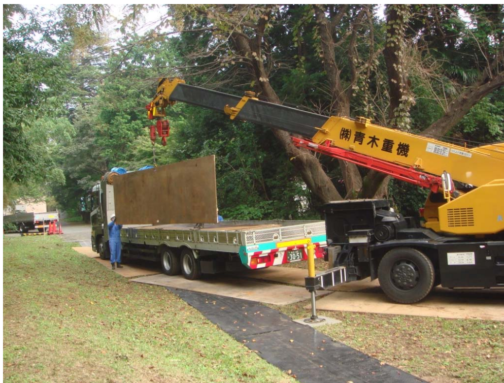
写真 4 車両進入用鉄板敷き作業
