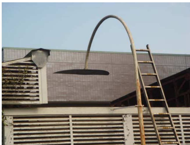
写真 2 大きなアームで建物外から設置された月光遮蔽板
