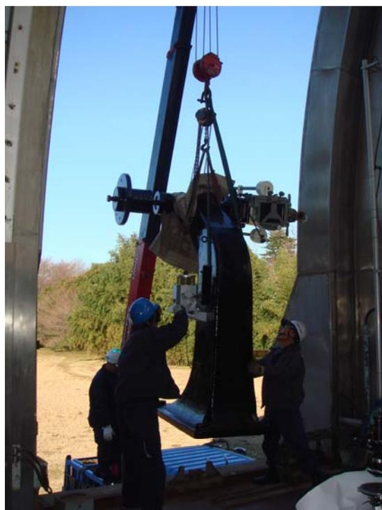
写真 4 スリットから搬入される望遠鏡
