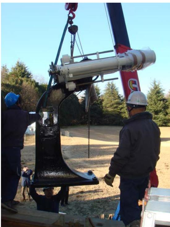
写真 3 クレーで吊り上げられる望遠鏡
