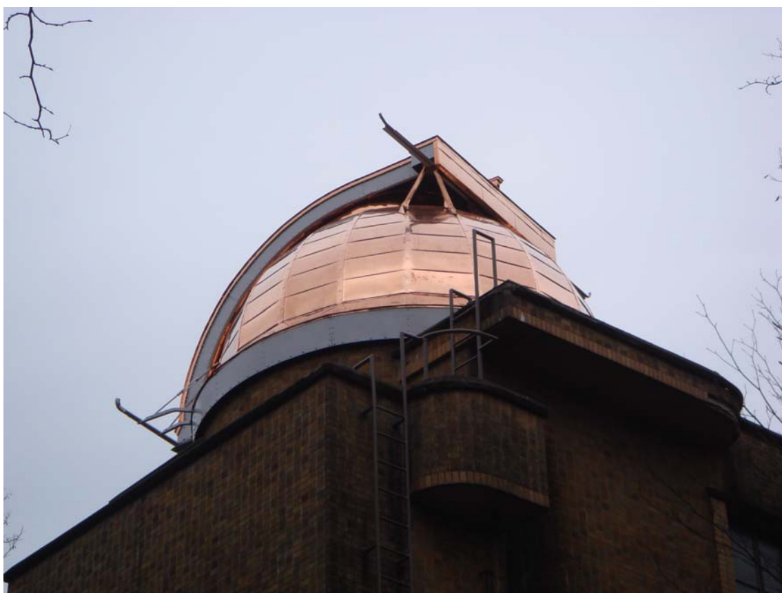
写真1 金ぴかに輝く補修された塔望遠鏡ドーム
