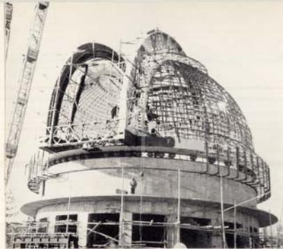
— 建造中の 188 種 (74吋) 反射望遠鏡ドーム建物
