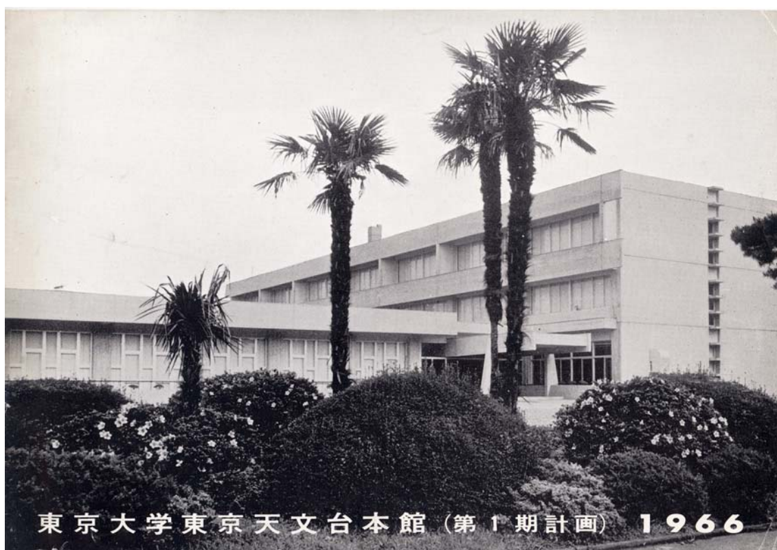
写真1 昭和41年（1966年）竣工した本館のパンフレットの表紙
