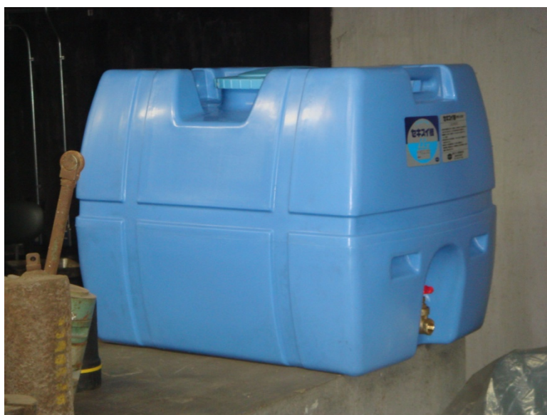
写真1 300リットルの水タンク
