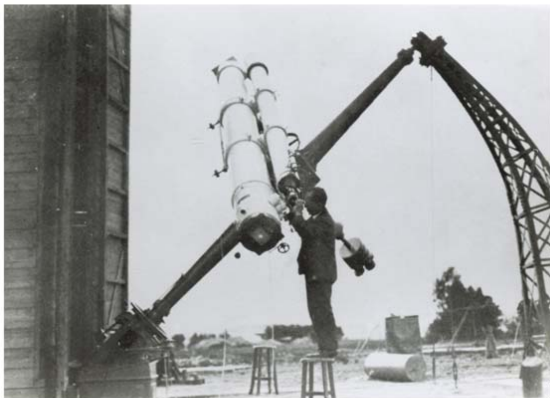
写真 2 昭和 11 年（1936 年）北海道女満別日食の赤道儀望遠鏡
