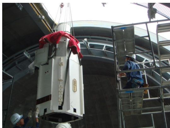
写真4 クレーンで吊られた筒頂部
