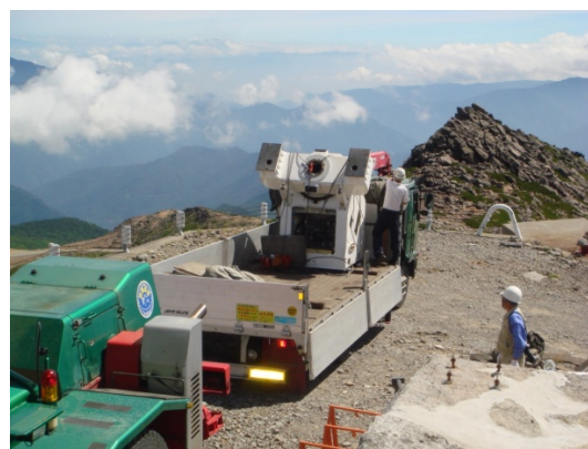
写真10 トラックに積まれた南架台
