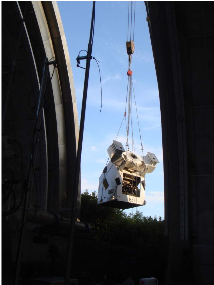
写真4 吊り込まれる望遠鏡南架台部
