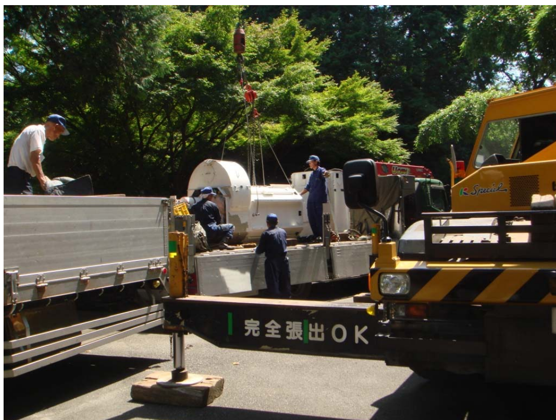
写真1 三鷹キャンパスでの4トントラックへの積み替え作業
