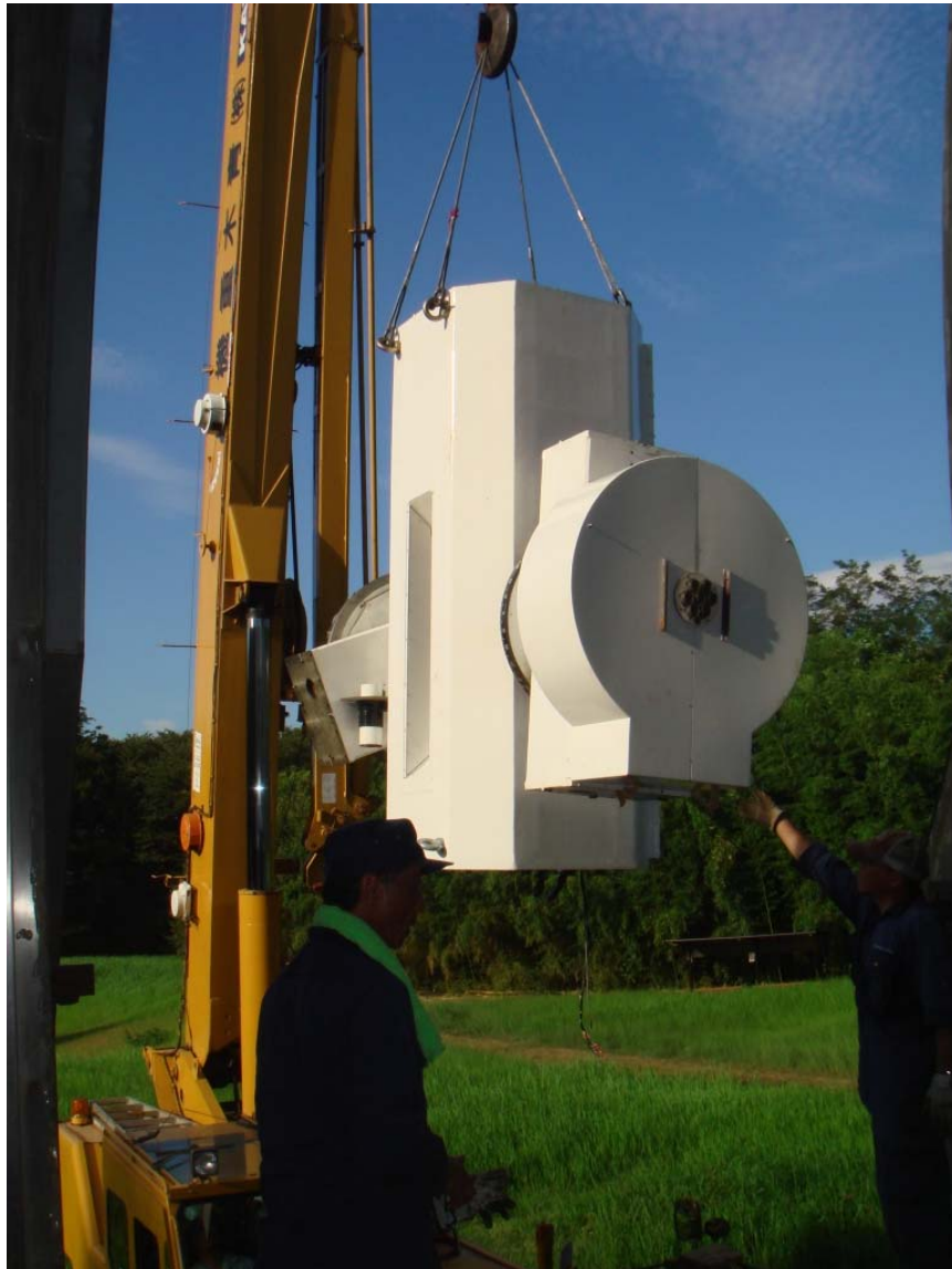
写真3 天文機器資料館に吊り込む望遠鏡中央部
