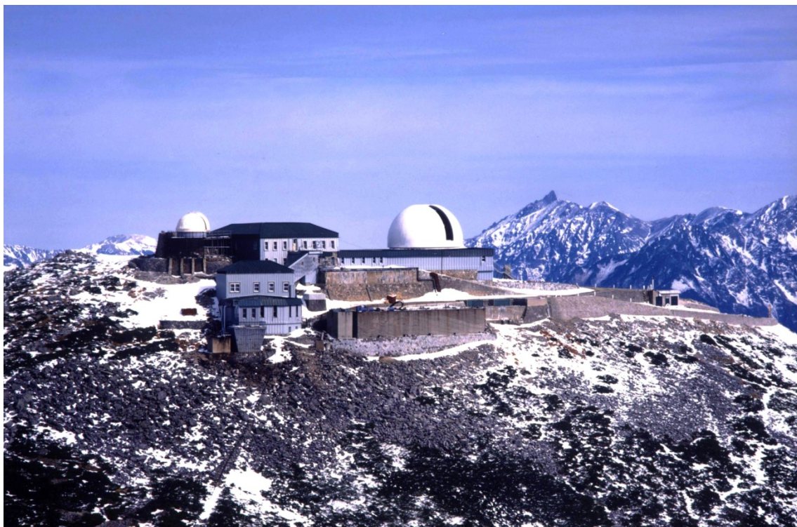
写真2 北アルプスの山々をバックに乗鞍コロナ観測所
