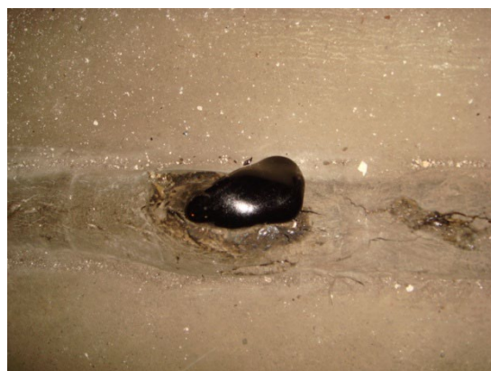
写真7 望遠鏡の載った檣の基礎と5階建ての建物の基礎の空隙のアスファルトが溢れだし、はみ出した様子
