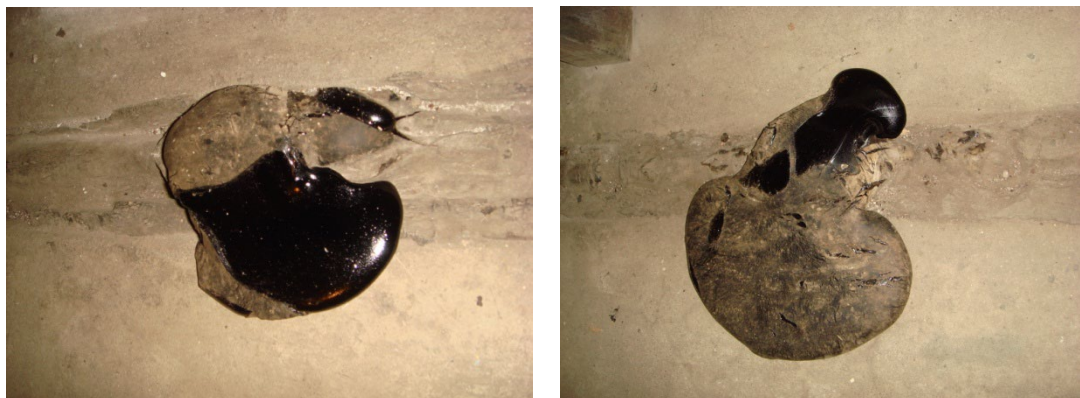
写真8 以前にも猛暑があり、溢れだしたアスファルトを突き破って今回現れた新しい噴き出し
