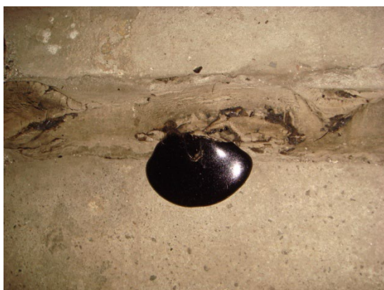
写真7 望遠鏡の載った檣の基礎と5階建ての建物の基礎の空隙のアスファルトが溢れだし、はみ出した様子
