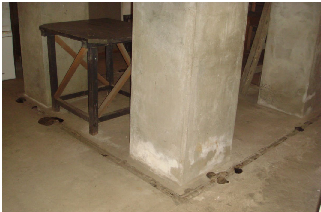
写真6 檣の基礎と建物の床の境界に詰められたアスファルト
