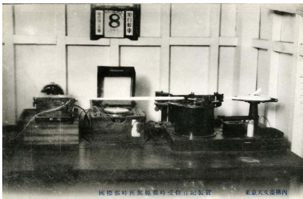
写真 15 国際報時所無線報時受信自記装置
