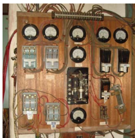
中桐製の配電盤
