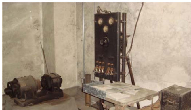
直流発電機と配電盤
