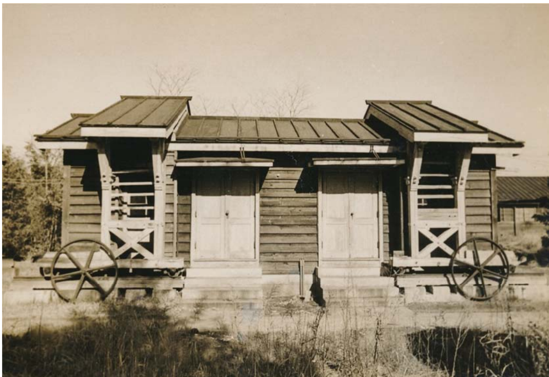
写真3 連合子午儀室の1棟
