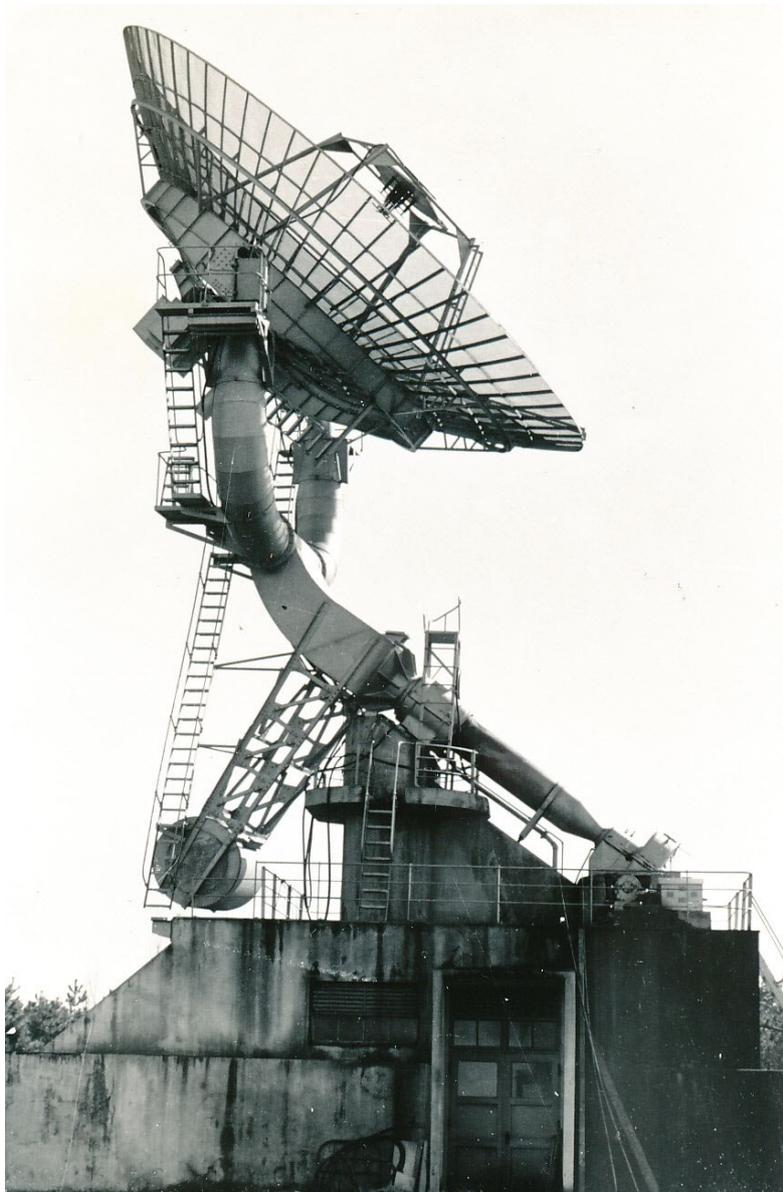
写真5 10mパラボラ太陽電波赤道儀望遠鏡
