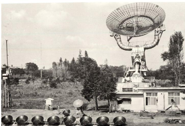
写真3 「ノイズ」にあった 10m パラボラ太陽電波望遠鏡とその周辺の干渉計
