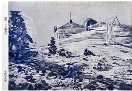
写真11 乗鞍コロナ観測所
