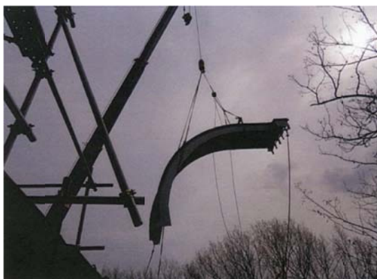
写真9 吊降ろされる扉
