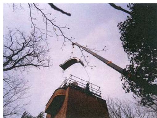
写真8 クレーに吊られた扉
