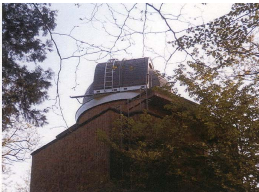
写真19 改修が終わり復元されたドーム
