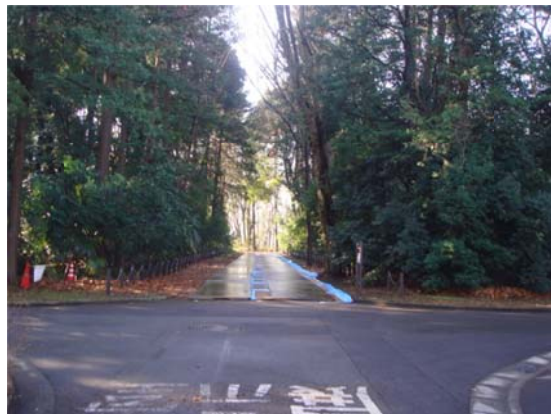
写真6 敷かれた鉄板
