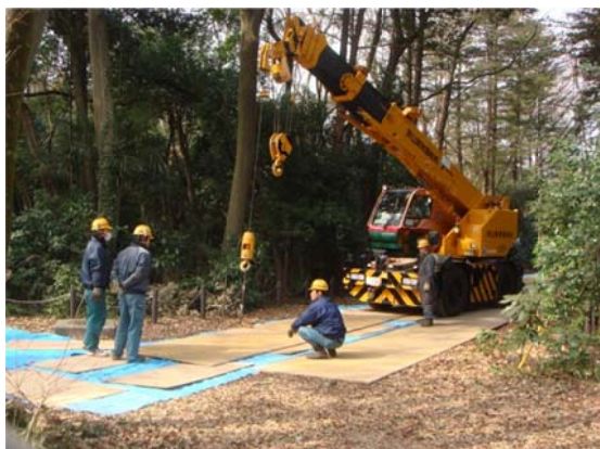
写真5 鉄板敷設工事
