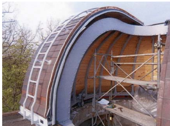
写真18 ドーム開口部戻された扉
