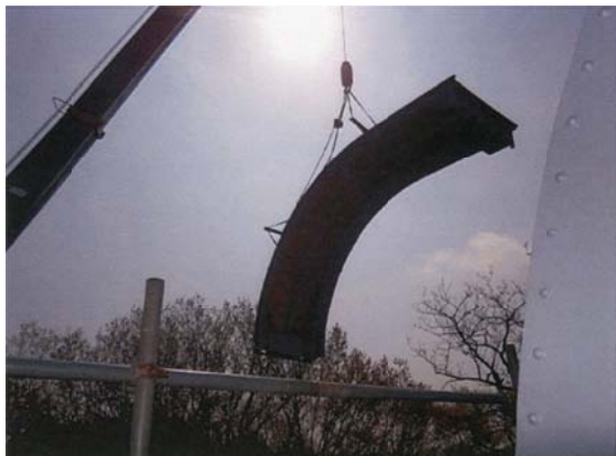
写真17 吊上げられるドームスリットの扉
