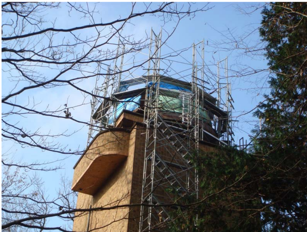
写真2 2009年のドーム葺き替え工事
