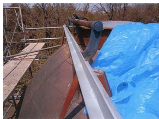
写真14 交換されたレール
