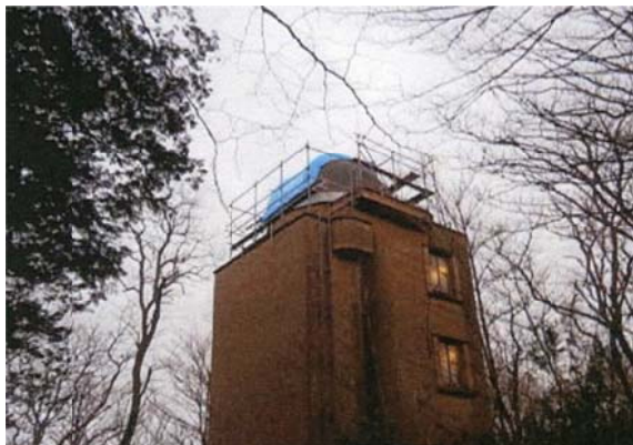
写真11 養生されたスリット部
