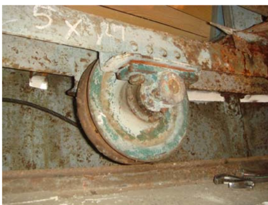
写真2 ジャッキで浮かされた車輪
