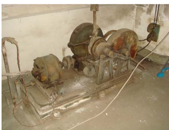
写真4 ドーム回転駆動装置
