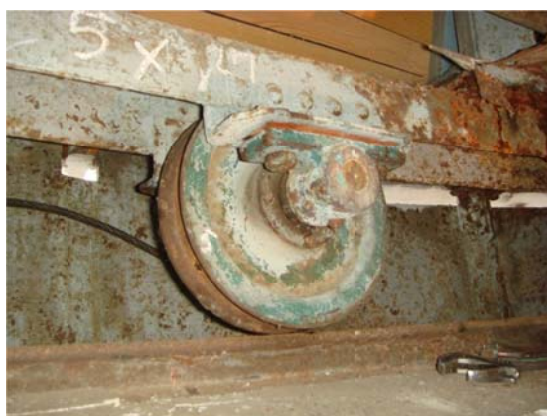
写真2 ジャッキで浮かされた車輪
