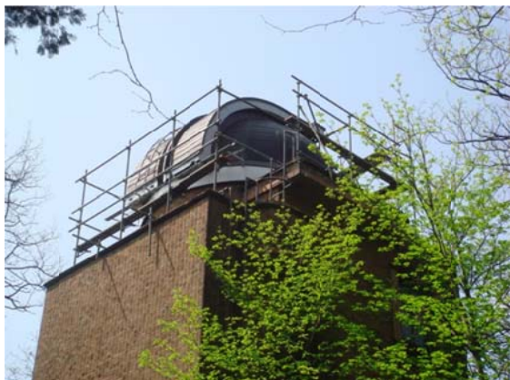
写真8 工事を始めたころ
