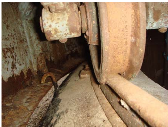
写真1 錆のひどい車輪-1
