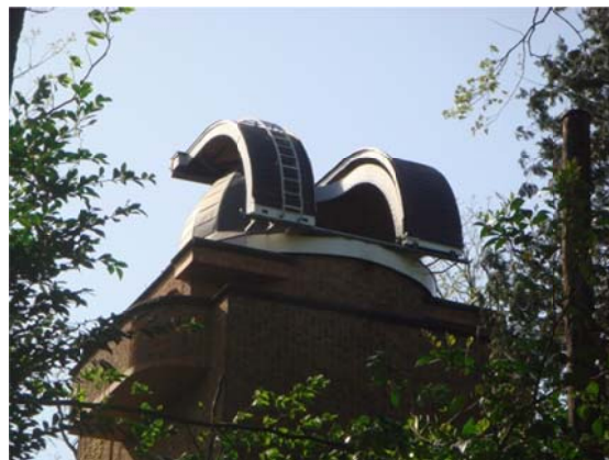
写真9 ドーム改修が終わった姿
