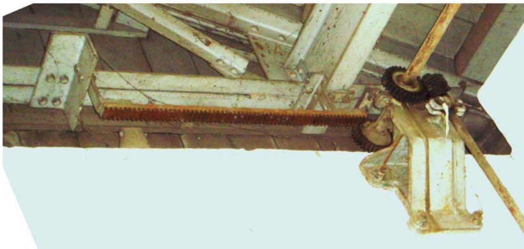
写真5 屋根開閉の平歯車
