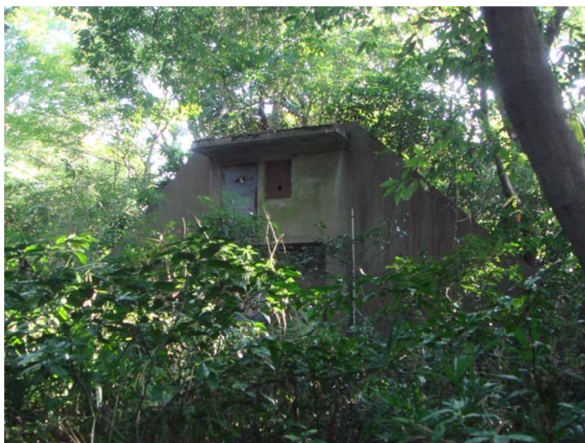
写真1 現在のゴーチェ子午環第一子午線標室
