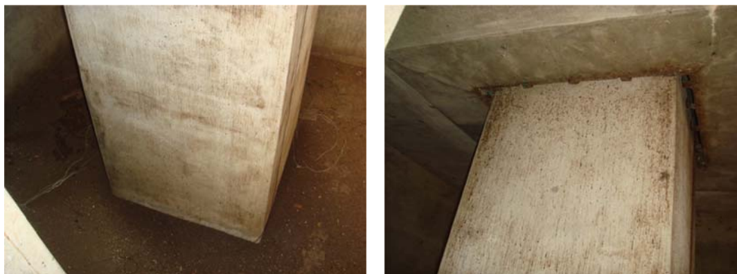
写真5 ゴーチェ子午環子午線票室1階から立ち上がったピア
