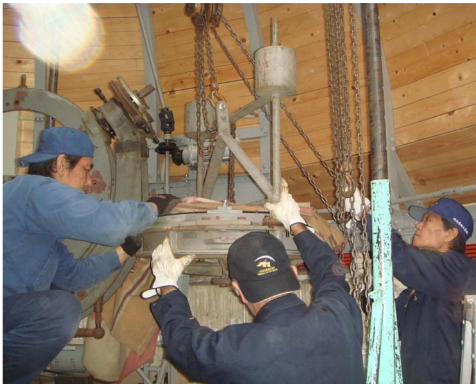
写真7 鏡の入ったミラーセルは水平状態で降ろされる
