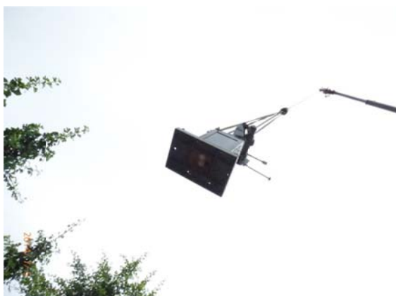
写真5 空中高く吊上げられた赤道儀
