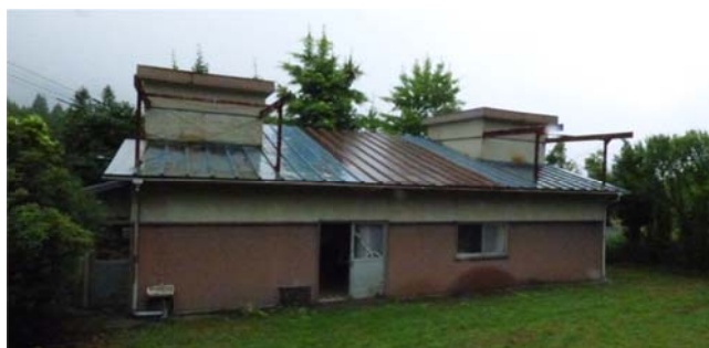
写真2 機材が保管されていたスライディンググループの建物
