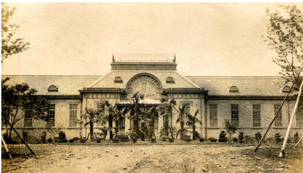
写真4 支柱に支えられた植生がある本館
